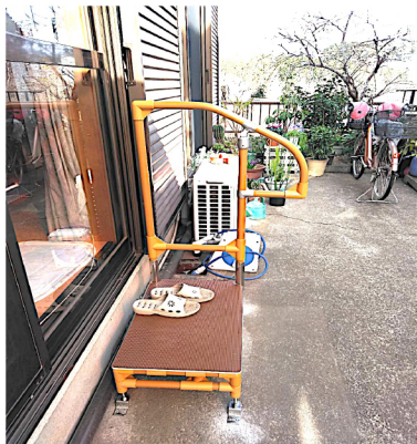
②段差の解消(固定する場合) 式台・スロープ等
