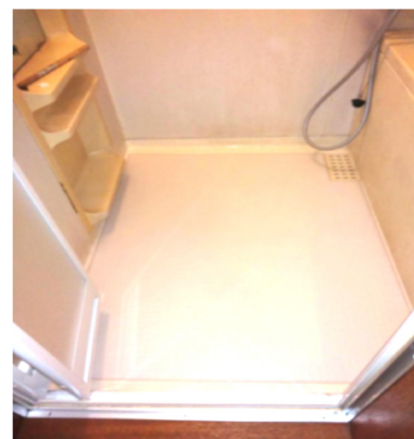
⑥浴室の床あげ、 滑りにくい床材に取替
