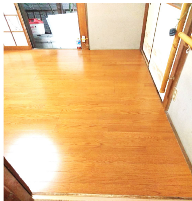
④滑りにくい床材に取替え 階段の滑り止め加工
