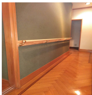
①手すりの取り付け
