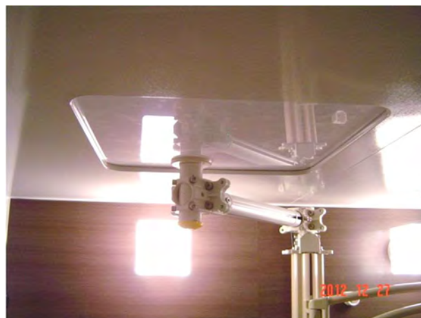
パイプジョイント式（天井裏固定）
